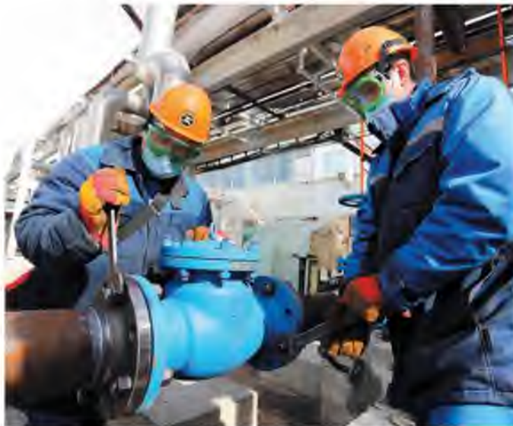
Узел выдачи аммиака на производство карбамида – стальная конструкция повышенной надёжности
